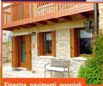
Finestre, pavimenti, poggiali
