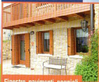
Finestre, pavimenti, poggiali
